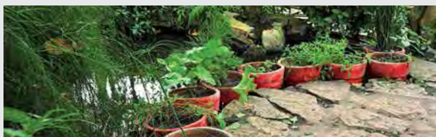
Bassin non sécurisé des grandes serres
