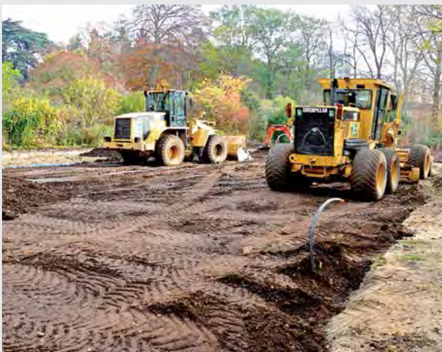
Printemps 2013 début des travaux de la Roseaie "des titans en action"
