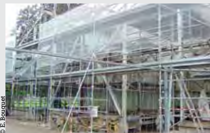
Les travaux ont été conduits entre juin et octobre 2013
