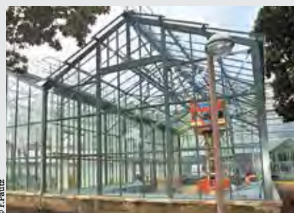
Fin des travaux
