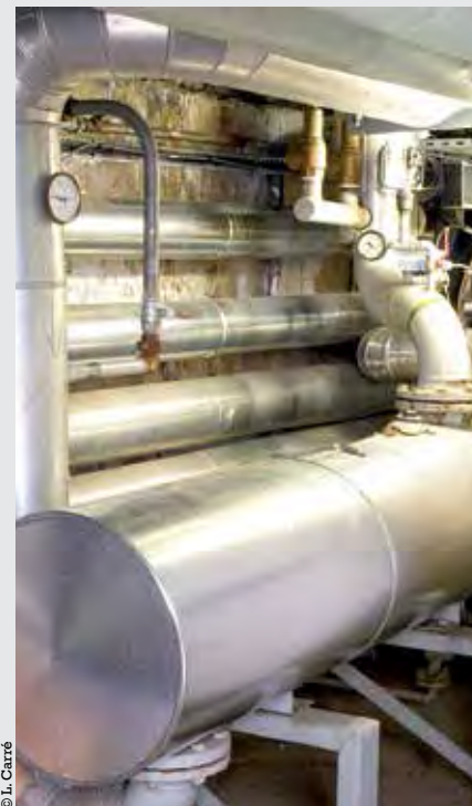
Vannes de distribution avec thermomètres de contrôle
