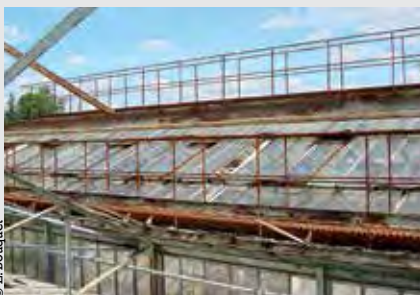
Etat des serres avant travaux
