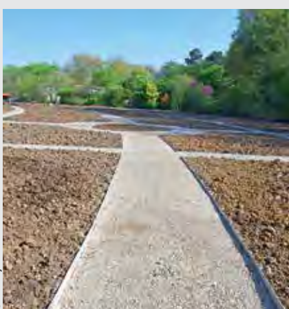
Vue des bordures métalliques et des allées prêtes à recevoir le stabilisé
