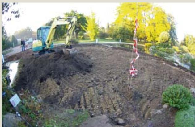
Un puisard est creusé de chaque côté de la Rize. Le décaissage est réalisé sur une profondeur de un mètre. Deux buses superposées (de 50cm de haut sur 100cm de large) sont disposées dans chaque trou, puis elles sont remplies de pouzzolane et recouvertes d'un géotextile pour éviter le mélange avec la terre qui sera disposée un peu plus tard.
